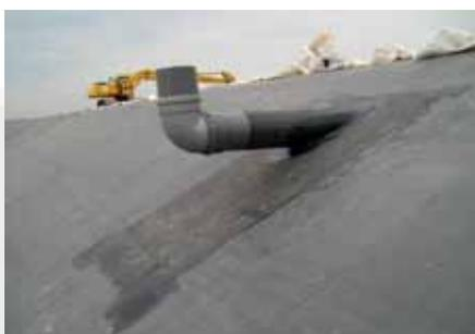
L'habillage des tuyaux et autres pénétrations, des coins intérieurs et des coins extérieurs est simple et rapide au moyen du QuickSeam FormFlash de Firestone, une bande d'EPDM non vulcanisée laminée sur une bande auto-adhésive de type QuickSeam Splice Tape. Ce matériau habille parfaitement chaque détail d'étanchéité quelle qu'en soit sa configuration.
