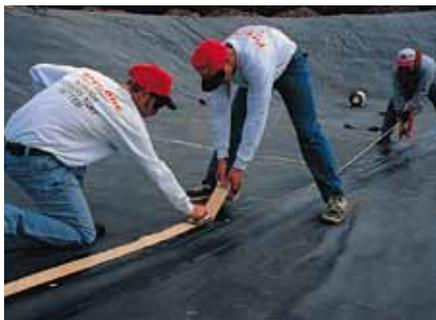
L'assemblage des nappes de Géomembranes EPDM peut être réalisé sur site au moyen des bandes QuickSeam Splice Tape (bandes auto-adhésives en butyle) et du primaire QuickPrime Plus.
