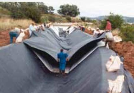
La Géomembrane EPDM Firestone est une géomembrane en caoutchouc synthétique vulcanisé. Sa structure chimiquement inerte lui confère des caractéristiques exceptionnelles.
